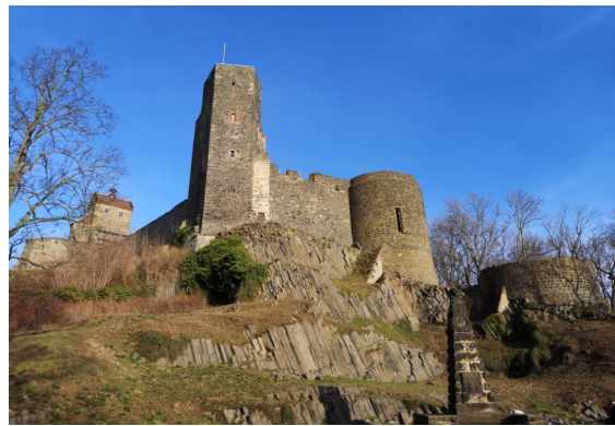
Basaltsäulen an der Burg Stolpen
